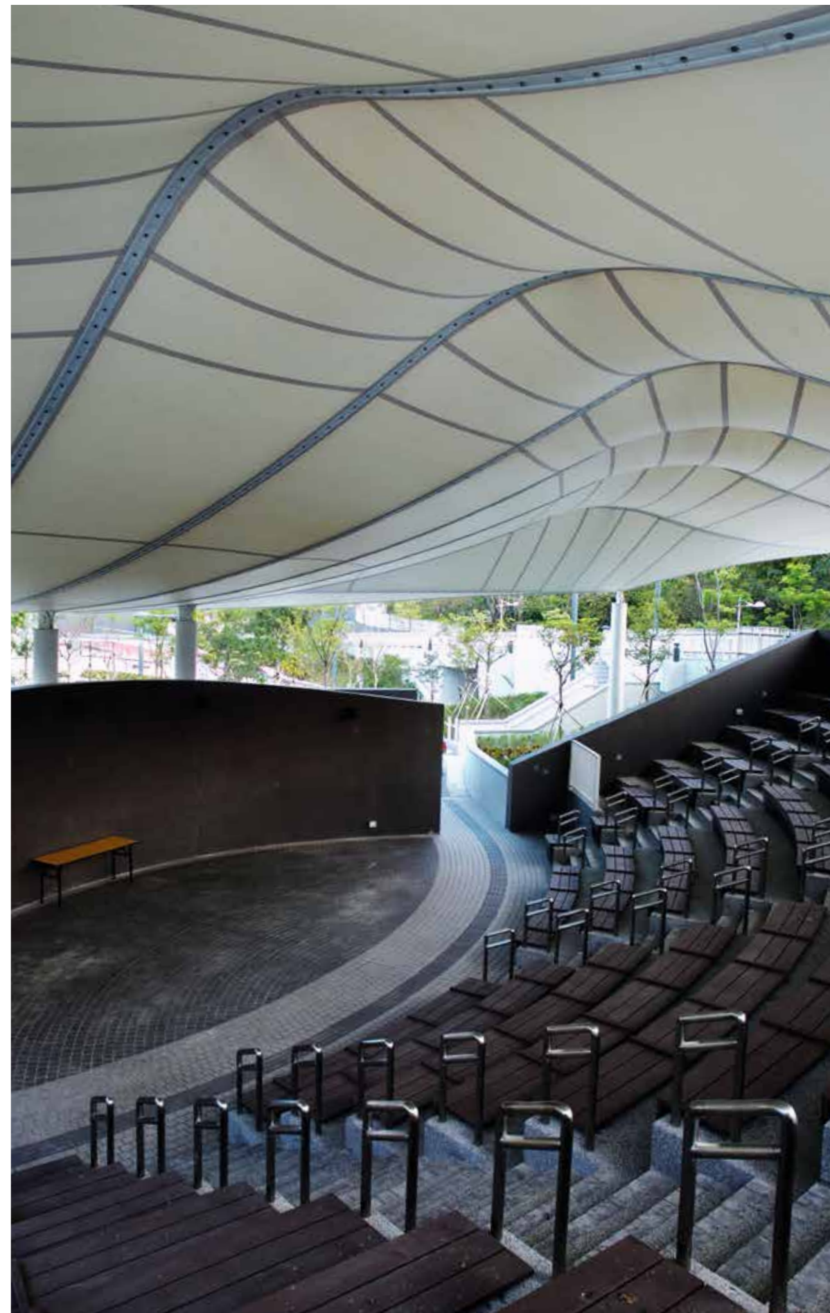
將軍澳市鎮公園的運動場露天劇場，距離住宅區180米，作為露天表演場地又不影響居民生活，聲學管理應該怎樣做呢？天幕可以擋雨又可以隔聲，表演聲音會從天幕折射到觀眾席，喇叭都安裝在座位下，座位最末端安裝了吸音板，外面則是石屎隔聲屏障。
