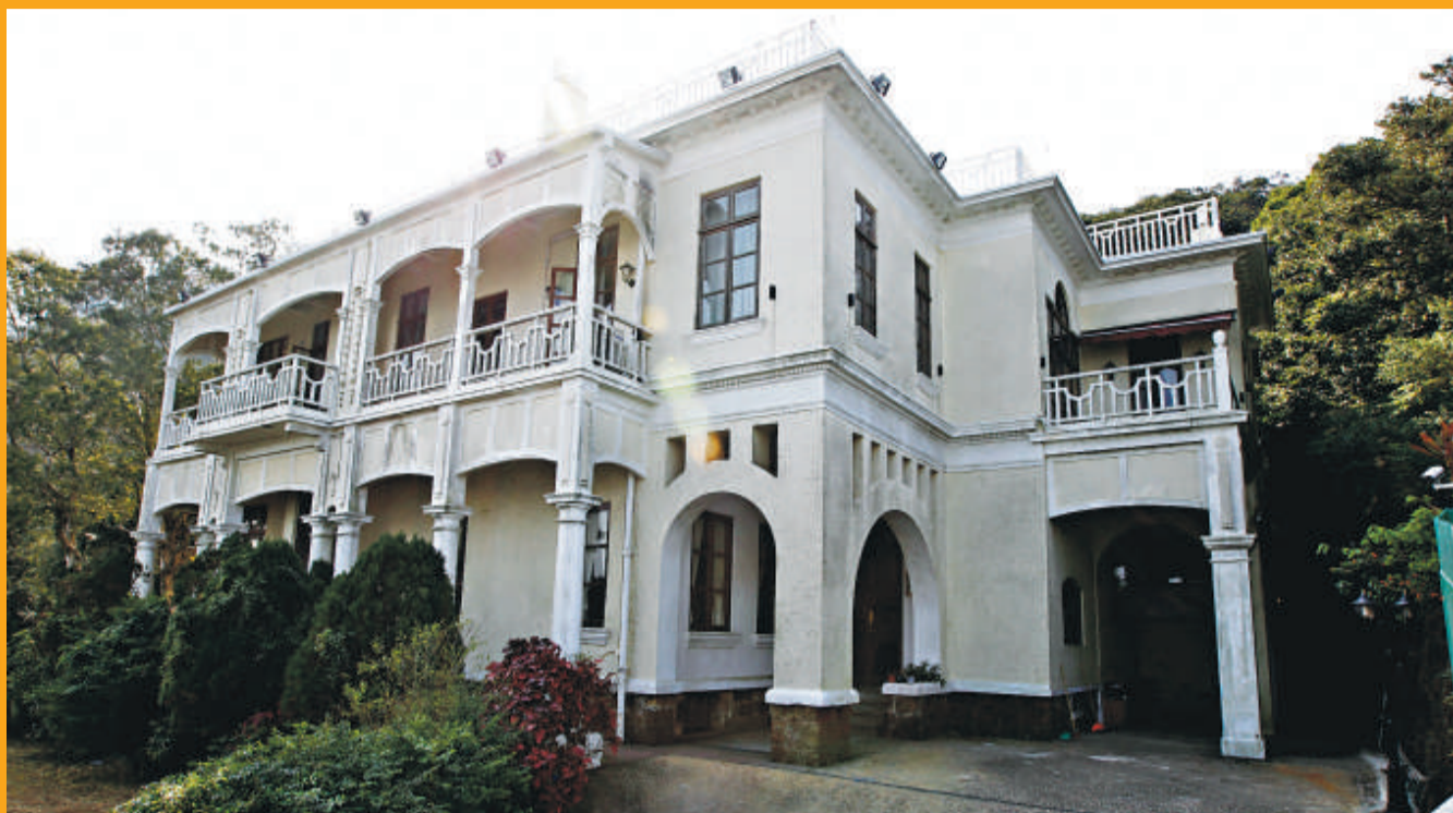
山頂盧吉道27號大宅有百年歷史，屬二級歷史建築，去年獲城規會批准活化改作酒店，引起社區關注組織反對。(李紹昌攝)
